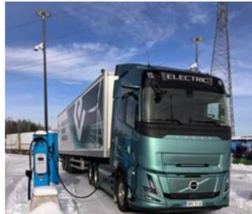
Kuva 2. Kotkan sataman latausasema
